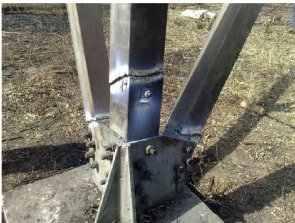
图 3-4 塔腿主材及八字铁切割工程实景图
